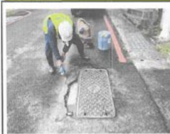
停車場出入口前：路面坑洞 AC修補
