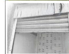
A棟：停車場外捲門修繕
