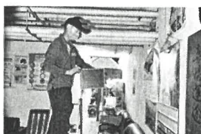
1121215 交大二餐地下室007
