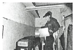
1121215 交大二餐地下室002
