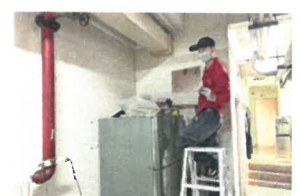
1130115交大二餐地下室002
