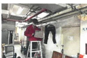
1130115交大二餐地下室005
