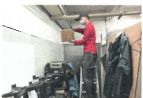
1130115交大二餐地下室003
