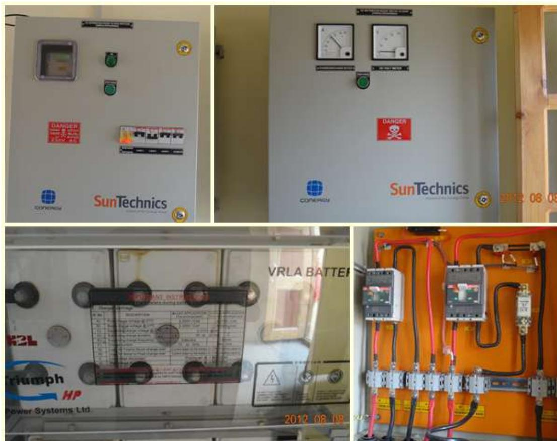
圖、15kW 太陽能發電系統的電池組(左下)及電力控制裝置
