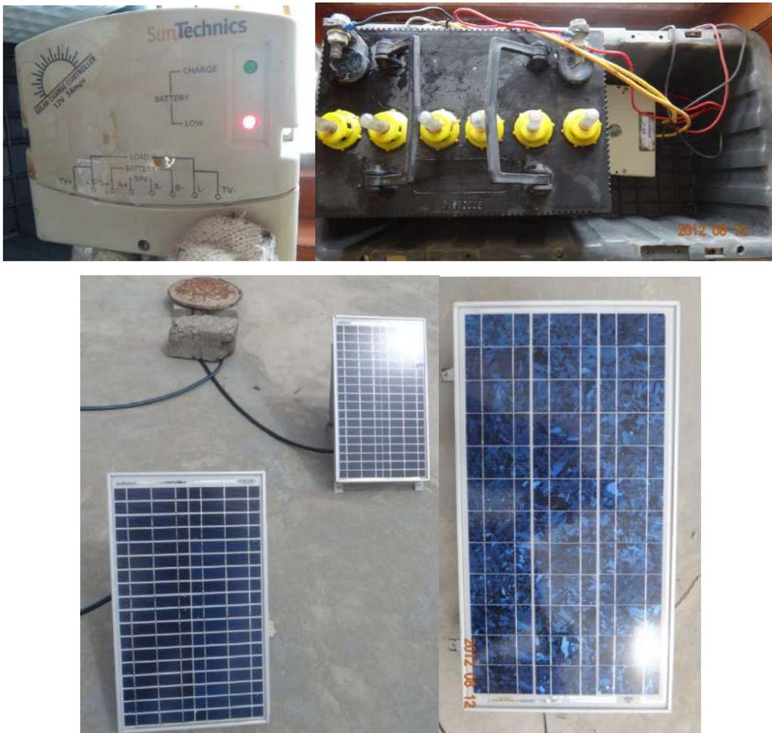
圖、GTM 照明系統(左上)、蓄電池(右上)、太陽能面板(下)之狀況
