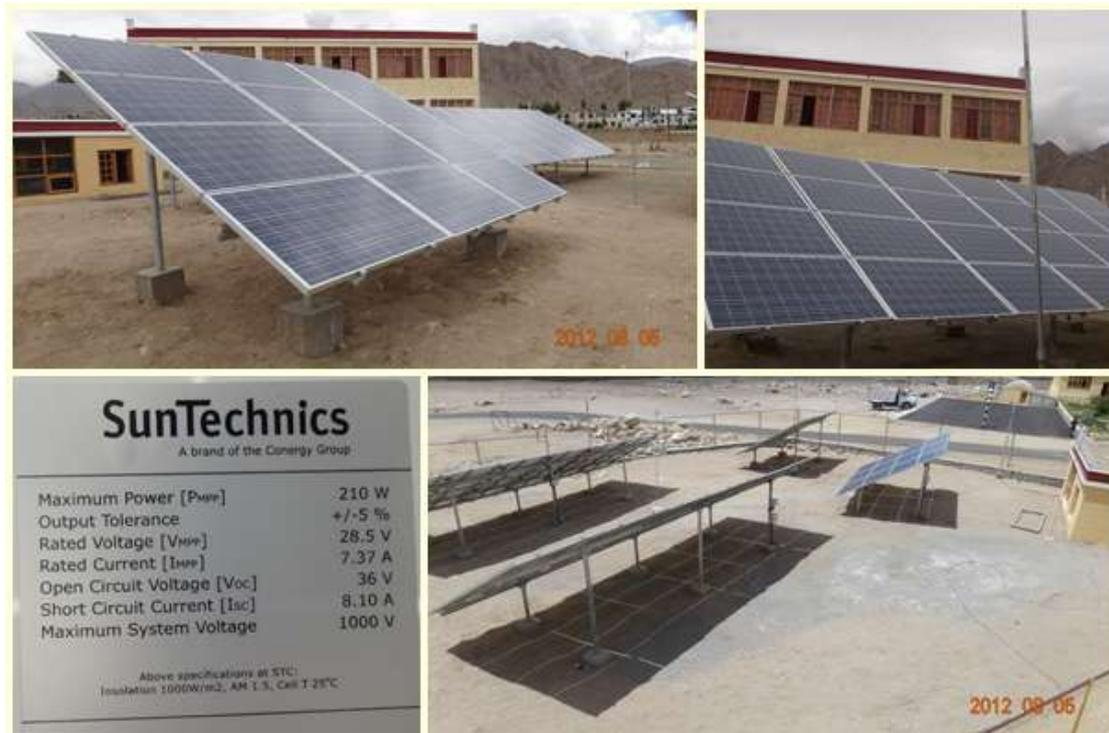
圖、Jamyang school 的 15kW 太陽能發電系統之太陽能面板
