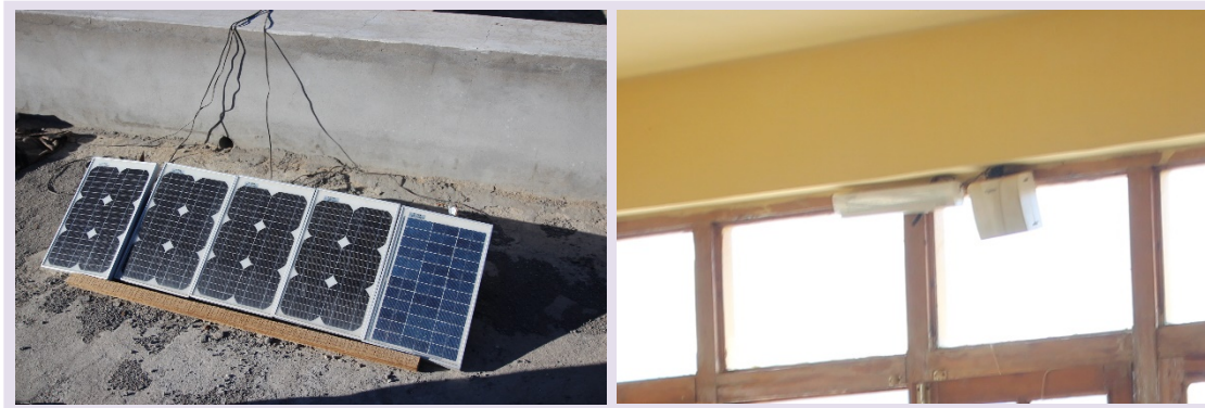
屋頂的小型太陽能板(左)，太陽能緊急照明(右)
