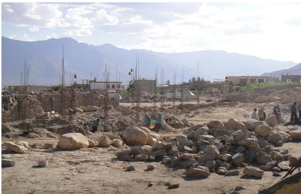
工人建造宿舍之情形
